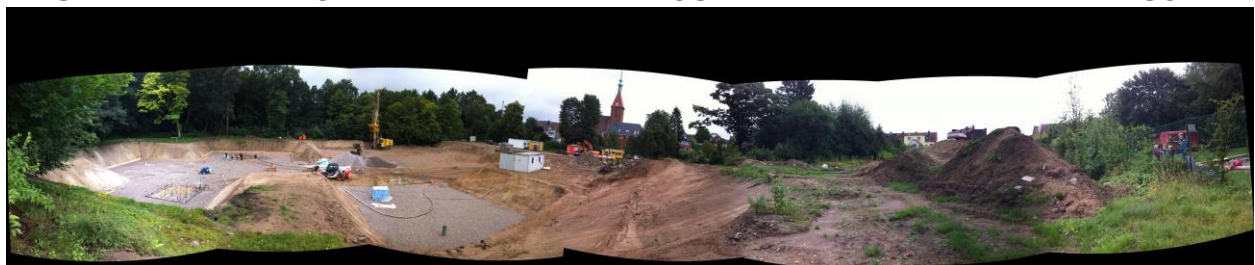
Abbildung 2: Panorama der Baustelle EDUR-Park mit Himmelsrichtungen.
