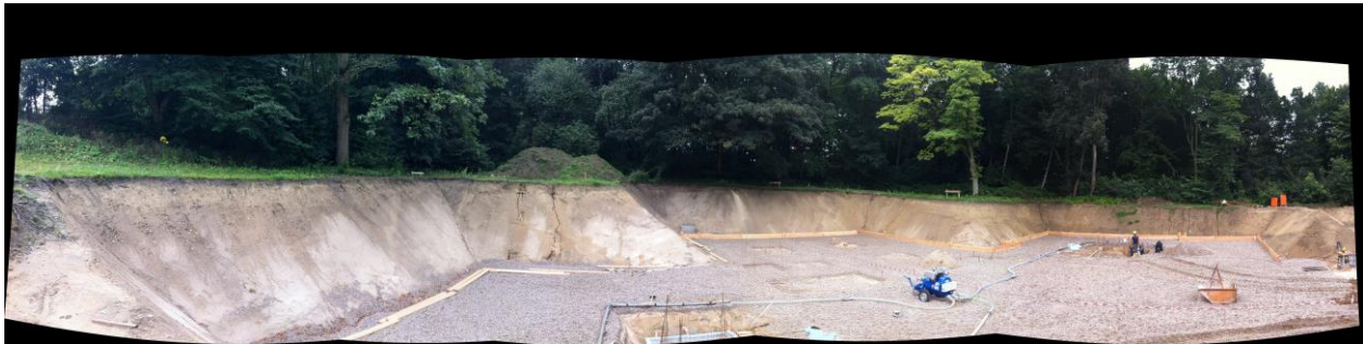
Abbildung 3: Panorama der westlichen Baugrube.
